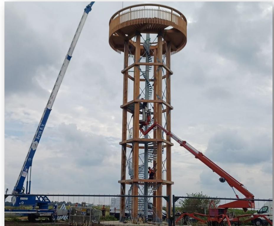
Figuur 2: De bouw van de uitkijktoren van de Ronde Hoep is gestart
